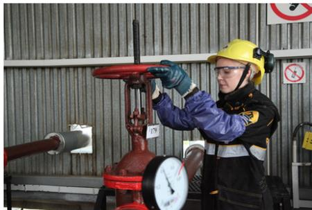
Рисунок 2 – Регулирование уровня в деаэраторе, непосредственно при помощи задвижки
