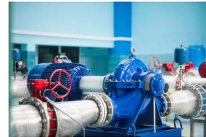
Рисунок 3 – Насос, при помощи которого осуществляется регулирование уровня в деаэраторах
